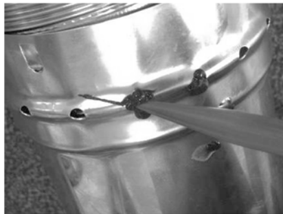
Figure 5 –Raccord flexible sur rigide pour la version APOLLO INOX
