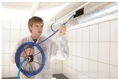
Imm. 39: Esempio: pulizia di un canale rotondo
