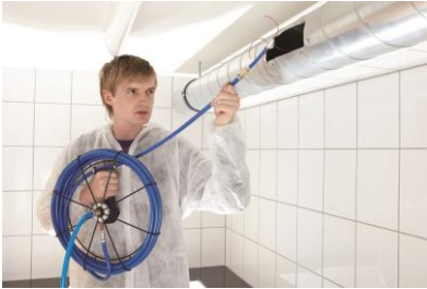
Fig. 56: Exemple d'application : Nettoyage d'un conduit
