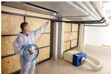
Fig. 67: Nettoyage de la conduite avec boule de guidage, fouet à air comprimé et aspirateur
