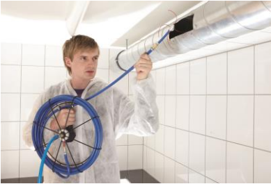
Abb. 5: Anwendungsbeispiel: Reinigung einer Rohrleitung
