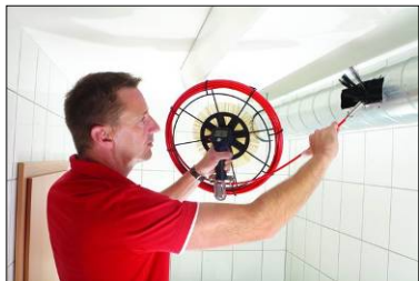
Imm. 36: Nettoyage d'un conduit d'air
