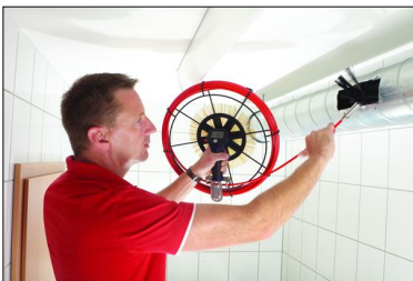
Abb. 6: Reinigung eines Lüftungsrohres
