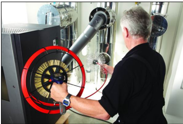
Abb. 5: Reinigung eines Edelstahlschornsteins
